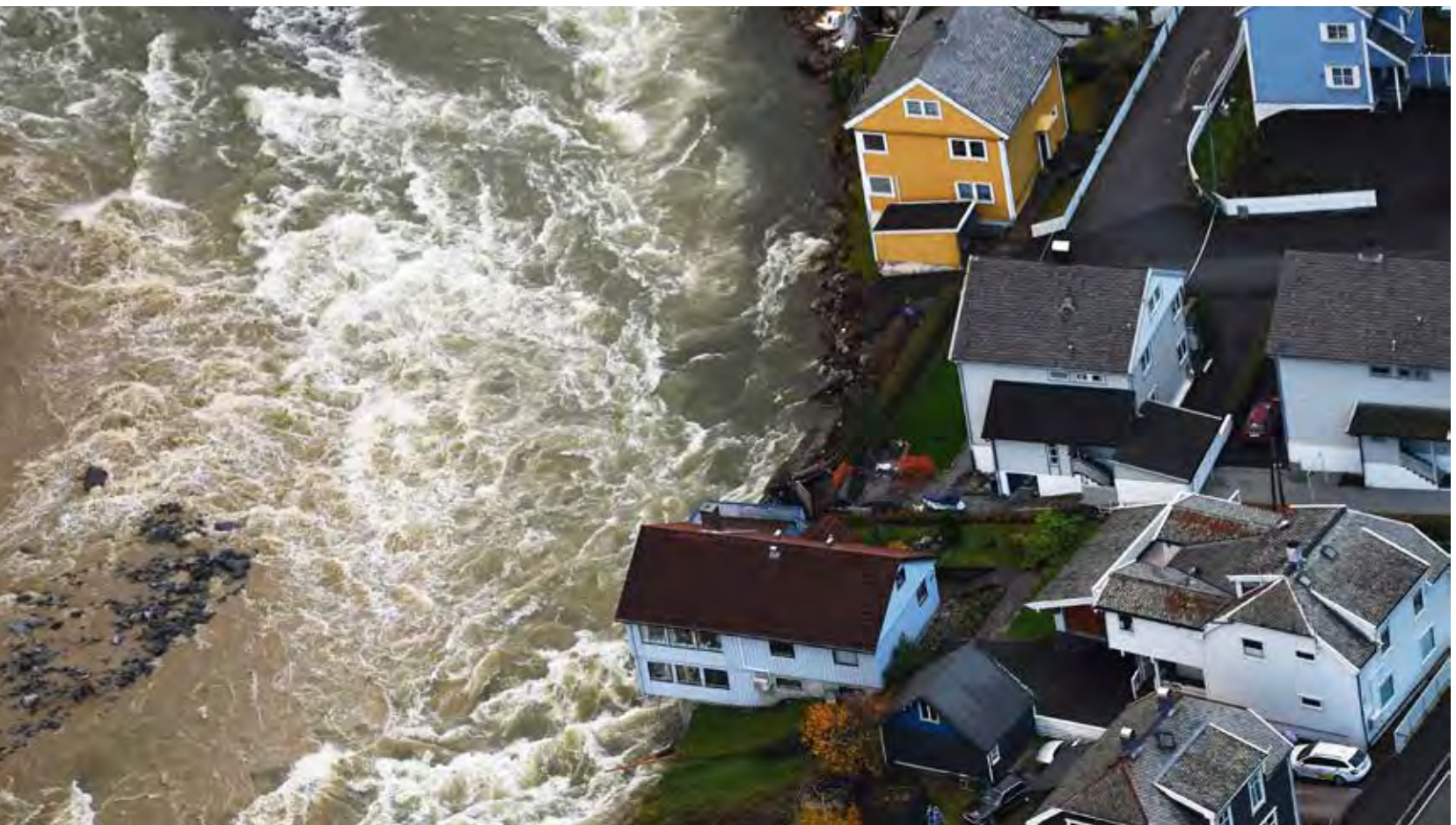
ODDA 29. OKTOBER 2014: Flommen i elva Opo gjør stor skade på flere hus. FOTO: Jan Kåre Ness / NTB scanpix
